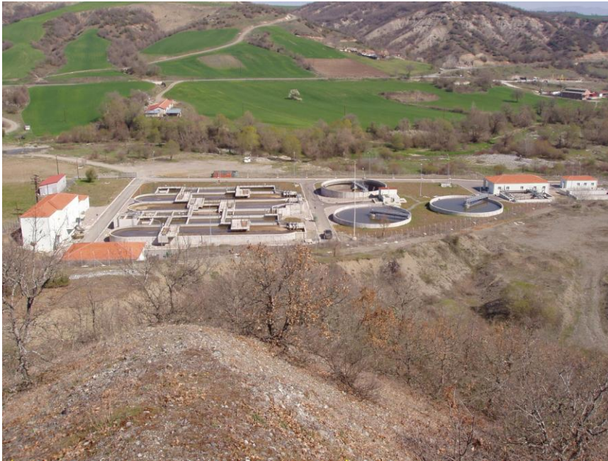
Εικόνα 18: Εγκαταστάσεις επεξεργασίας λυμάτων Γρεβενών
